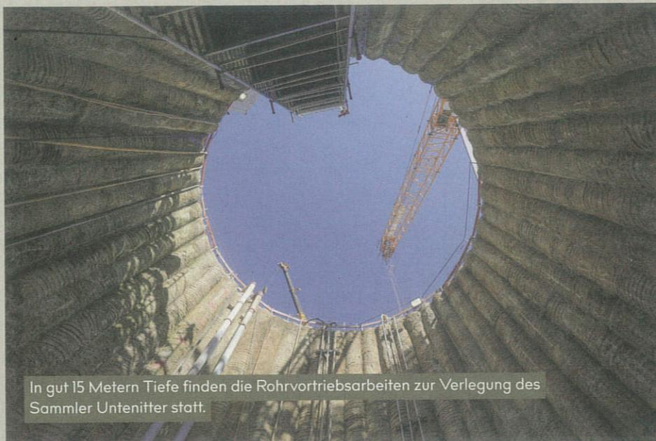
In gut 15 Metern Tiefe finden die Rohrvortriebsarbeiten zur Verlegung des Sammler Untenitter statt.
