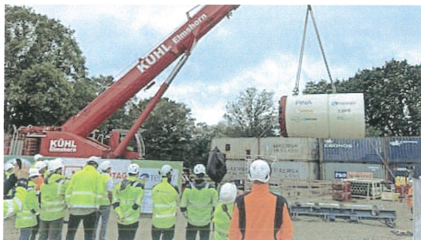
50 Tonnen wiegt der Erdbohrer Pina, der in Henstedt-Ulzburg am Dienstag in die Erdgrube gesetzt wurde. Der Bohrer hat ein Kilometer Erdarbeiten vor sich.
