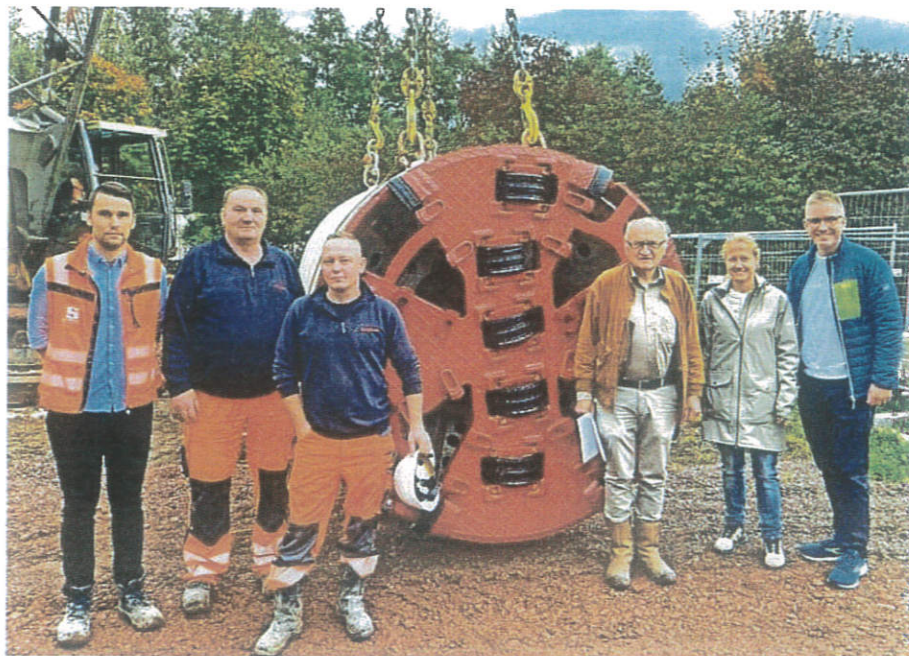
Bürgermeister Kai-Achim Klare (von rechts), Bauamtsleiterin Melanie Graß, Planungsingenieur Bernhard Keller und das Team von der Sonntag-Baugesellschaft begutachteten den 28 Tonnen schweren Bohrkopf, bevor dieser eingesetzt wurde.
